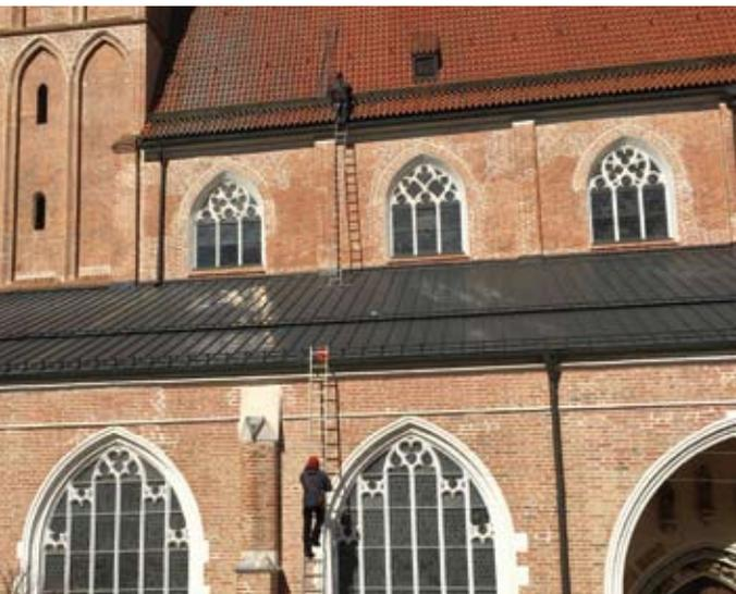
Im Februar mußten nach dem heftigen **Sturm Sabine** auch am Dach von St. Jodok **Reparaturen** durchgeführt werden.
